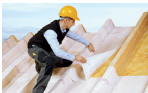
Montage Damprem bij daksanering van buiten
