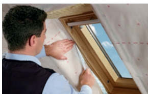
Aansluiting dakraam
