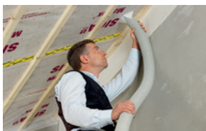
Montage damprem bij inblaas-isolatie
