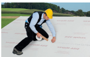
Montage damprem bij dakspantenisolatie
