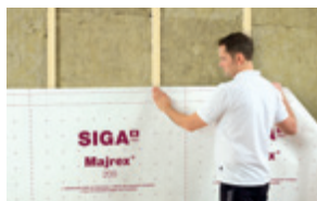
Montage dampremmer op houtconstructie
