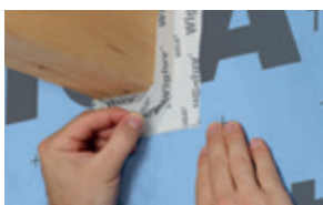
Doorvoer bij gevelfolie
