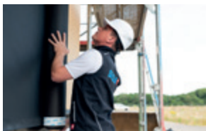
Montage gevelfolie bij open gevels
