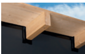
Doorvoer gevelfolie bij open gevels
