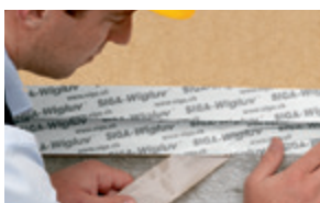
Houten wand naar beton
