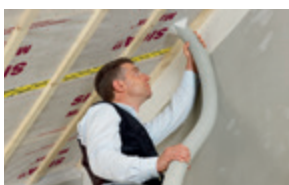
Montage dampremmer bij inblaas-isolatie
