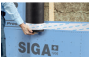
Montage gevelfolie bij gesloten gevels
