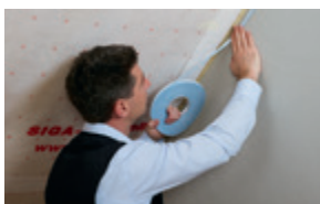
Dampremmer naar gepleisterde wand
